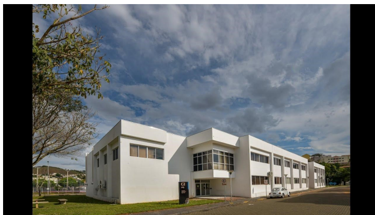
Figura 5.1: Instituto de Física e Química (IFQ)
